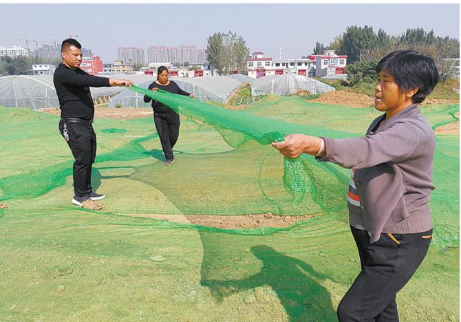
10月17日,黄河路中段景观提档工程施工人员对工地进行覆盖,避免黄土裸露产生扬尘污染环境。本报记者 姜涛 摄
