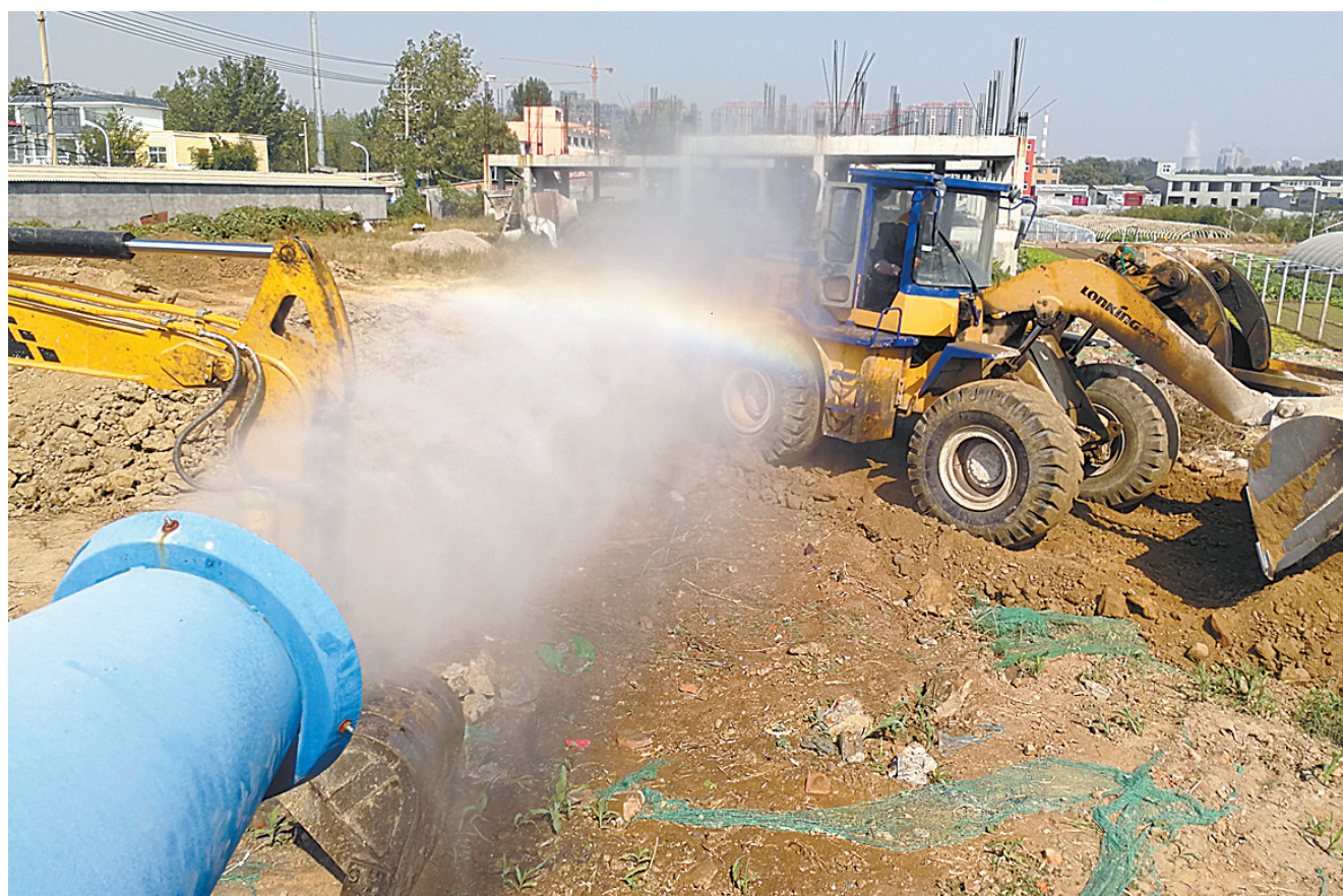
施工不忘防尘
