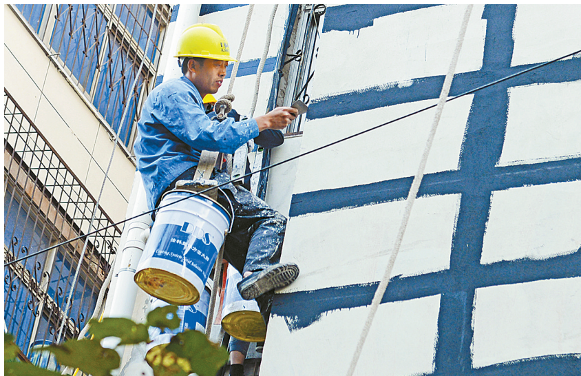
10月14日,一位工人在市区朝阳路区域老旧小区改造施工现场为居民楼外立面做防水层。为改善人居环境、美化城市形象,本报记者 王尧 摄
