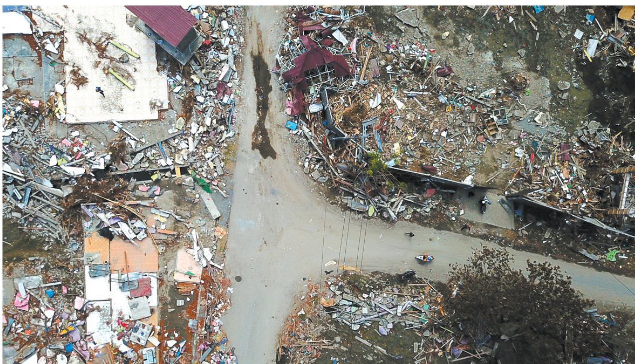
这是10月8日在印度尼西亚中苏拉威西省帕卢航拍的倒塌房屋。这是过去5年来印尼发生的最严重的自然灾害。
