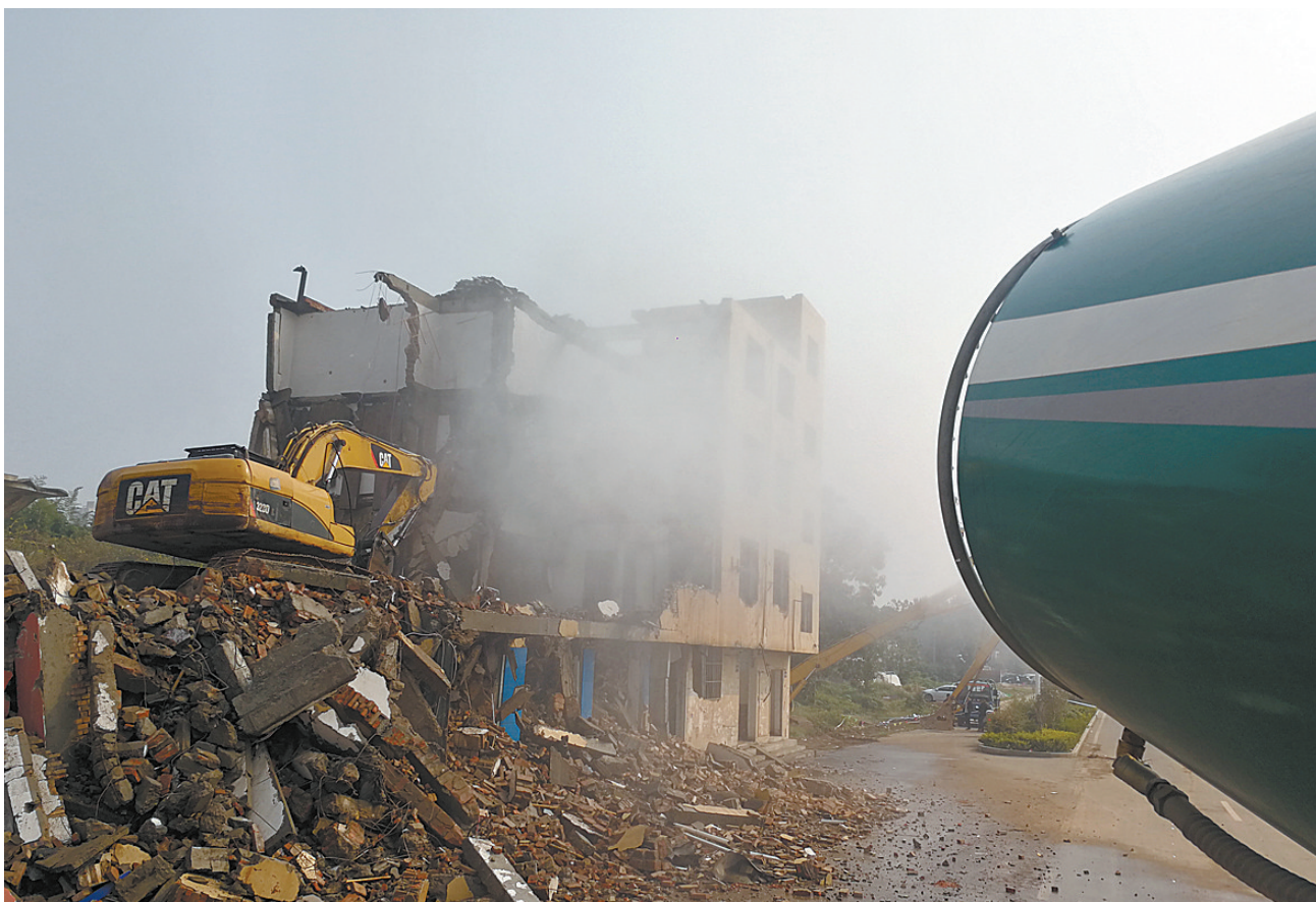
10月8日,在市区黄河路一工地破拆现场,施工方在工作的同时进行喷淋降尘,避免扬尘造成环境污染。本报记者 姜涛 摄
