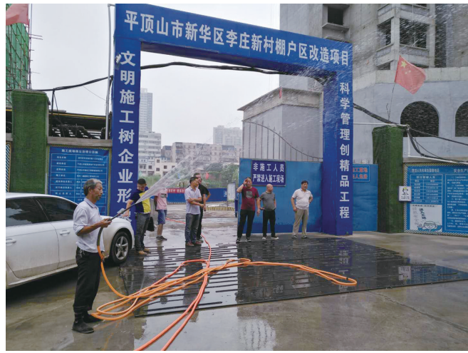
新华区辖区工地扬尘环保工作现场。王平安 摄
