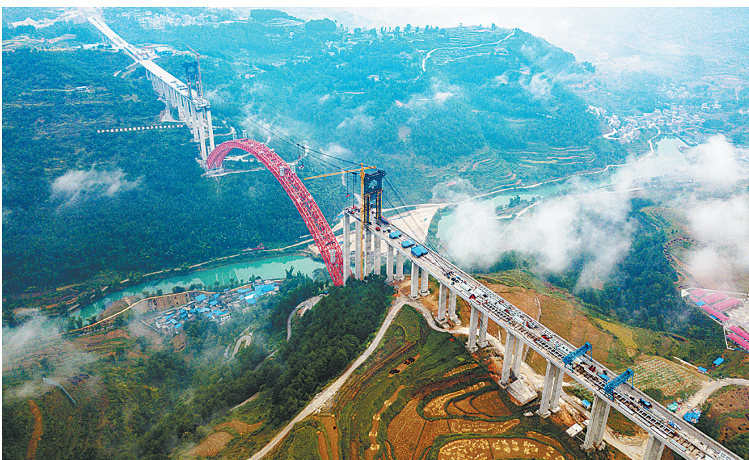
打通“断头路”:贵州大小井特大桥建设进入冲刺阶段
