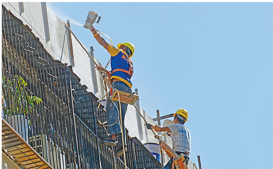
美化老旧小区墙体
