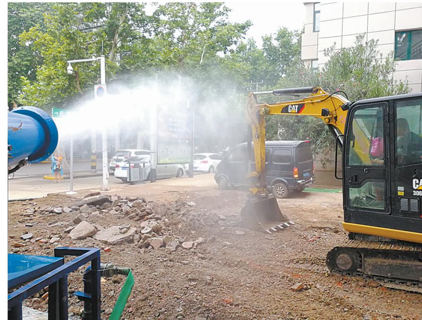
8月29日,一辆雾炮车在联盟路改造工程现场喷淋降尘。为做好环境污染防治工作,市市政公司路桥处在施工现场配备了雾炮车进行喷淋,并及时对黄土裸露区域进行覆盖,避免造成环境污染。本报记者 姜涛 摄
