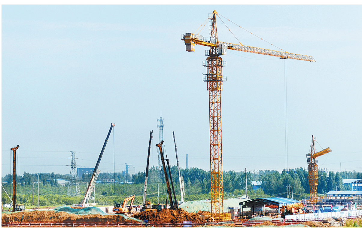
加快建设郑万高铁平顶山西站站房
