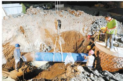
27日深夜,施工人员进行新管道吊进作业坑
