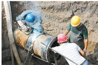
28日上午,施工人员在对接改移管道进行焊接
