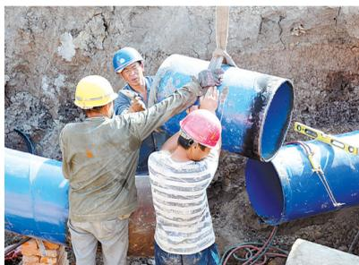
28日上午,施工人员在吊装改移管道
