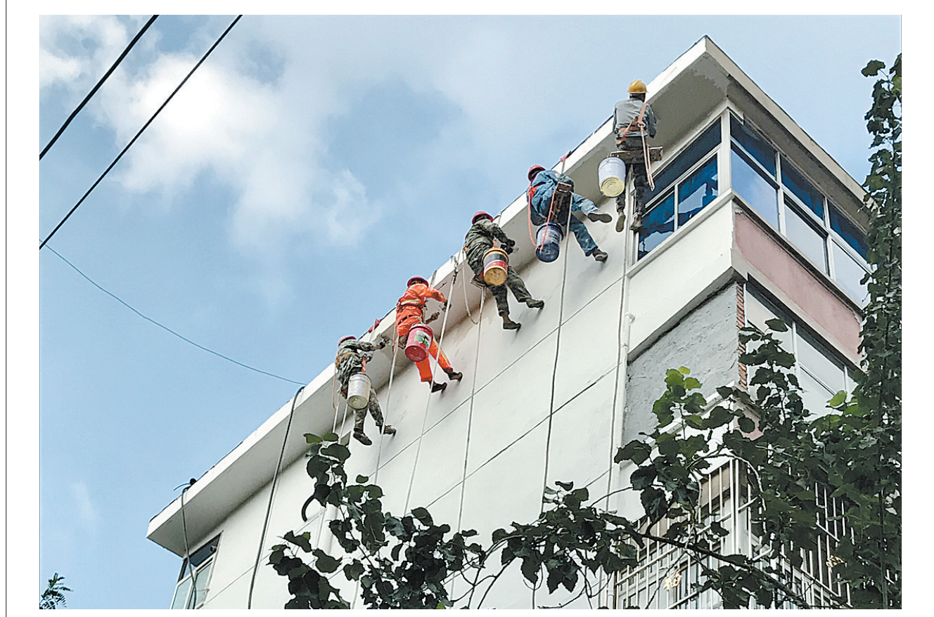
老旧小区、背街小巷换新装 按照“一街一主题、一巷一特色”的改造原则，8月26日上午，新华区住建局组织曙光街街道、湛北路街道等相关街道及施工单位的20名工作人员，对老旧小区、背街小巷的外墙墙体进行集中美化。目前启明街已完成沿街外立面乳胶漆补涂，曙光街街道沿西社区25号院11栋楼整体立面完成基础处理、底层腻子批涂。老旧小区、背街小巷同步“换上新装”。 本报记者 毛玺玺 摄
