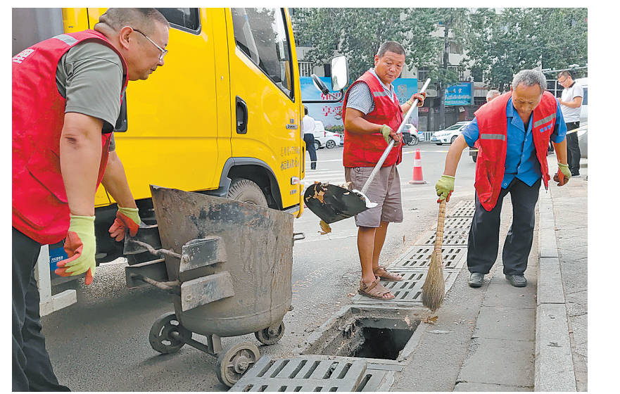
疏通排水管网 8月27日下午，市城管处维修二队员工在疏通建设路与新华路交叉口处的窞井及管道。为助力我市“四城联创”，连日来，该队组织员工对全市排水管网进行先期筛查，又组织车辆及机械对有淤堵现象的排水管网进行全面疏通，确保排水管网排水顺畅。 本报记者 牛智广 摄
