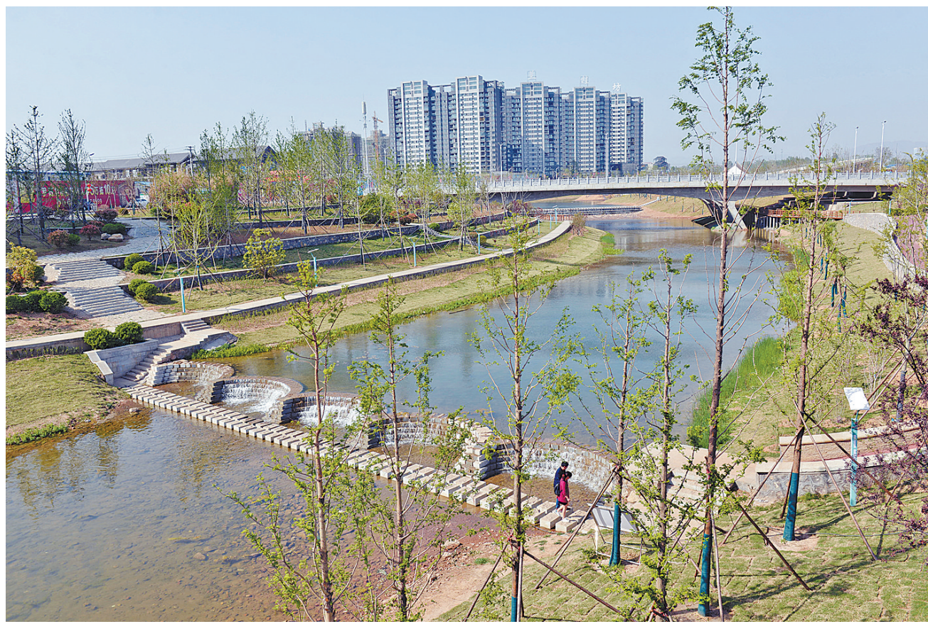
洗耳河综合整治 8月25日下午，汝州市民在秀美的洗耳河畔游玩。洗耳河发源于该市大峪镇老婆寨，全长36公里，流域面积205平方公里。去年4月，该市启动洗耳河综合整治及黑臭水体治理工程，一期治理工程长度9.8公里，二期工程长4.5公里，包括疏挖河道、岸坡堆砌、新建防汛路、两岸道路硬化绿化等，打造生态、自然、亲水的城市人居环境。 本报记者 牛智广 摄
