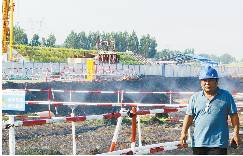
8月23日,一位工人从郑万高铁郑县段工地的围栏喷淋降尘装置旁走过。该项目建设单位在施工现场周围安装了围栏喷淋降尘装置,加强日常管理,消除扬尘隐患。 本报记者 王尧 摄
