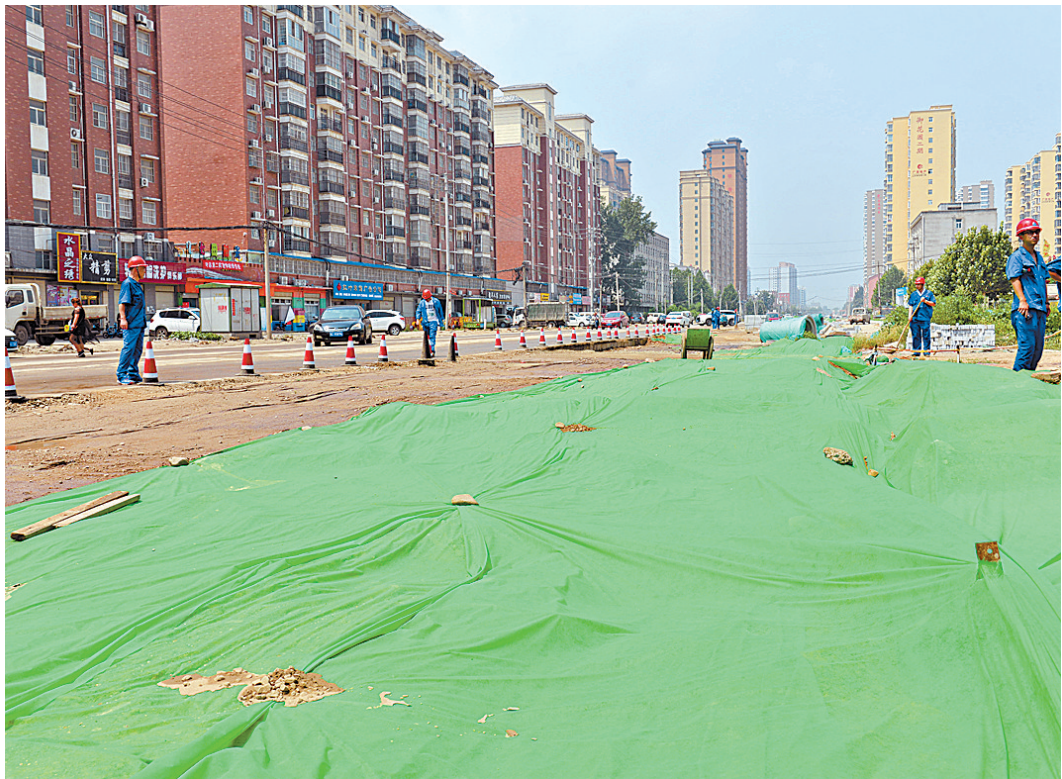
道路施工 防尘先行
