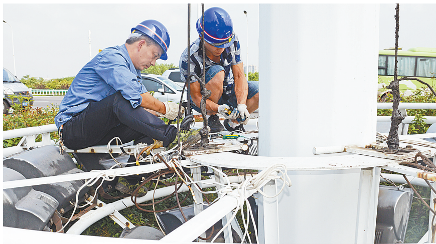
8月20日,新城区路灯所工作人员在宁洛高速路口维修高杆灯线路。为提升景观效果,美化人居环境,该所组织技术人员配合云台车、吊车等机械设备对辖区主干道沿线和游园、公园内的景观灯、高杆灯进行集中升级改造,助力“四城联创”。
