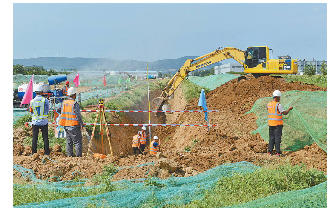
8月16日上午,施工人员在高新区东一环路工程施工现场忙碌。高新区主干路网有10条道路列入了打通断头路建设范围,目前,东一环路、开发一路、开发二路已开工。为确保道路在建设的同时有效抑尘,该区从开工伊始就做好防尘抑尘工作,对裸露施工土地加盖防尘网、设立车辆冲洗设施同时,喷雾、喷水抑尘。
