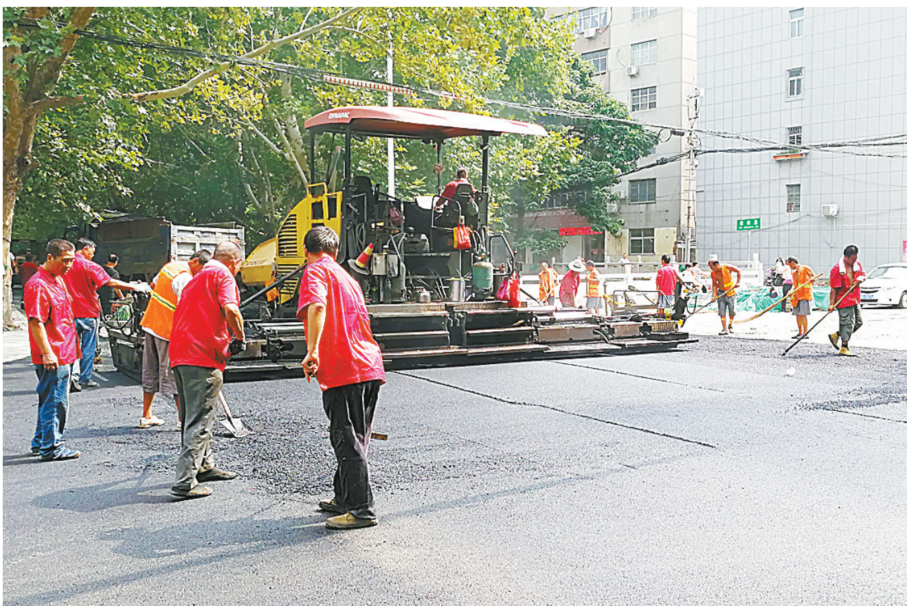
维修改造道路
