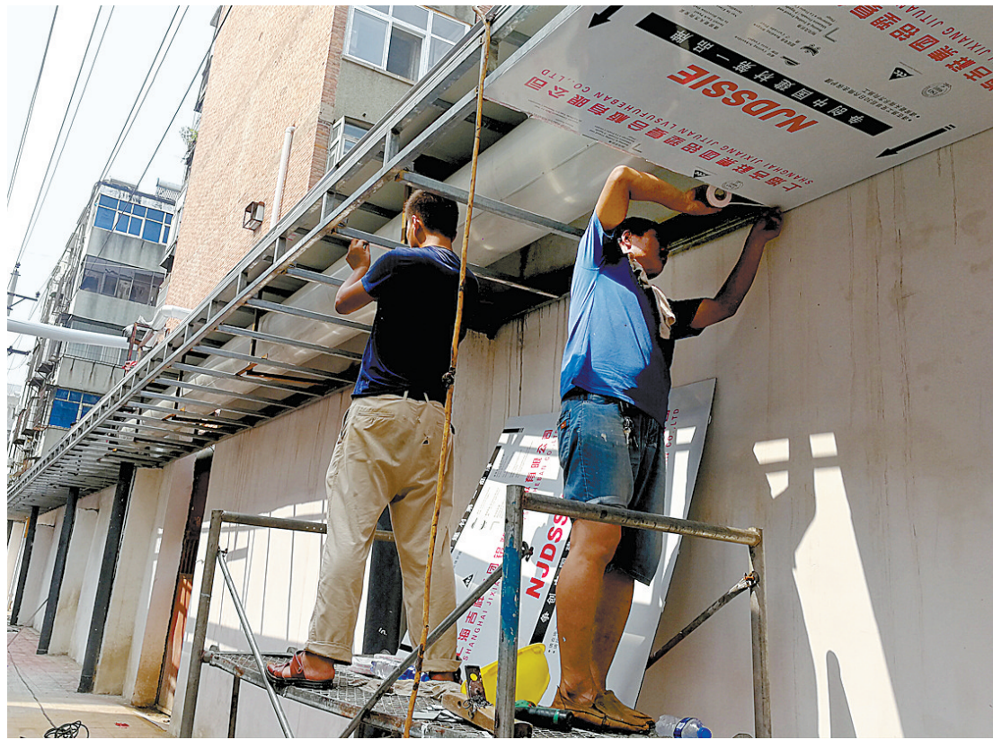
改造老旧小区
