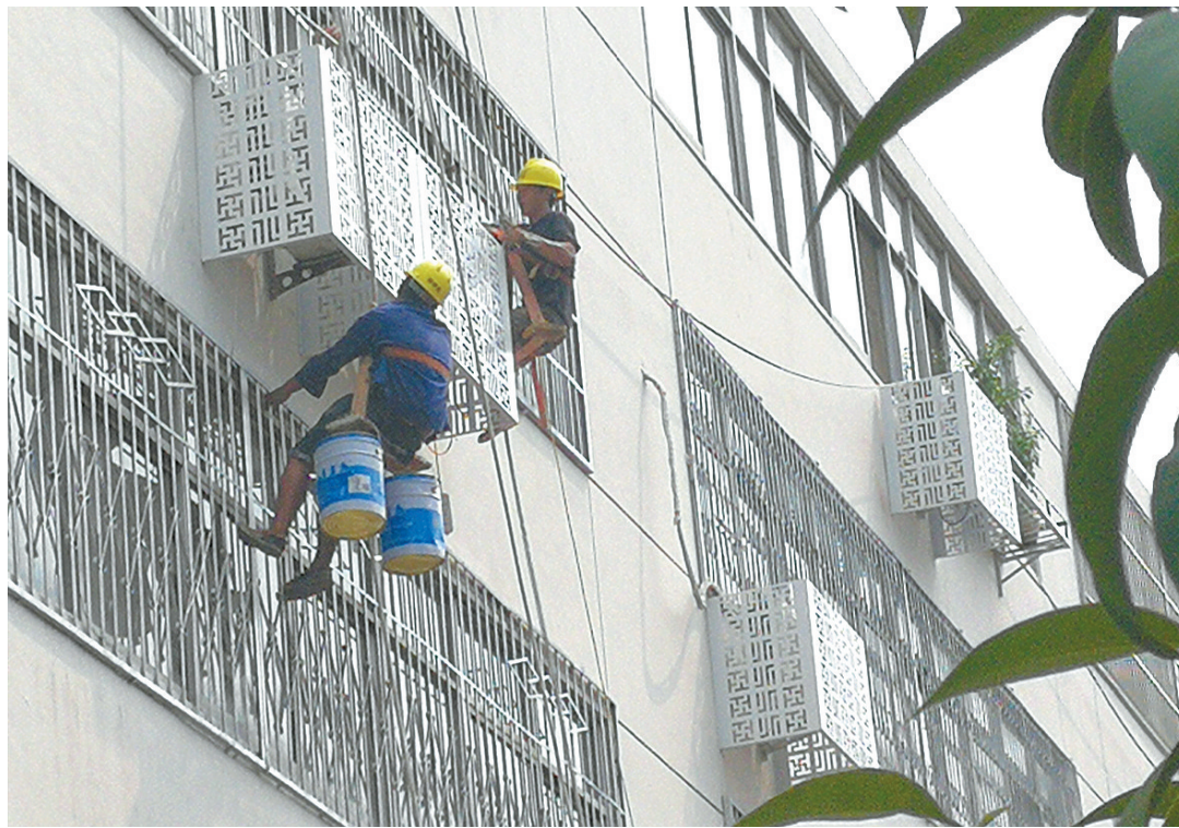
安装空调护网
