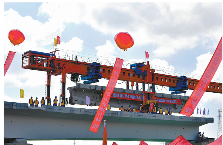
福平铁路正式进入铺架阶段
