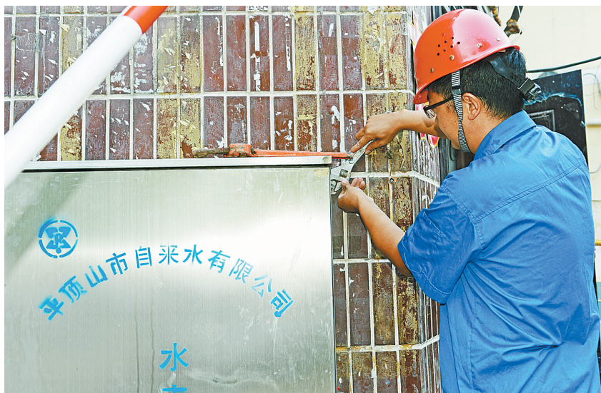
改造供水设施
