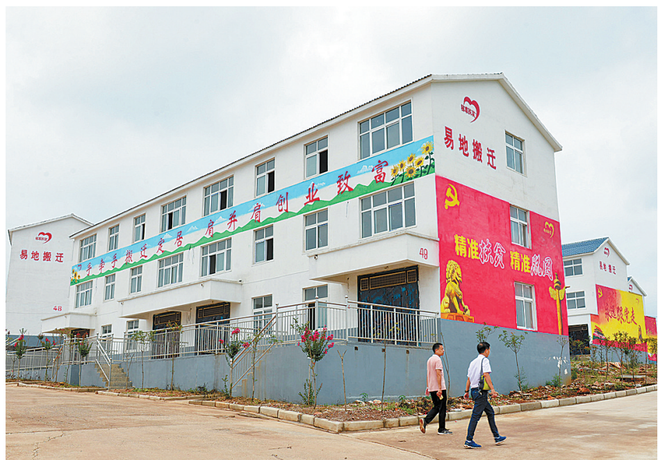
8月3日,村民从余家花园小区内走过。 余家花园是易地扶贫搬迁安置小区,位于观音堂林站崔家村,占地158亩,建设安置房388套,计划安置建档立卡贫困户187户713人,安置对象为崔家村、赵沟村、崔家村、马堂村、宋沟村等5个行政村的建档立卡贫困户。 本报记者 牛智广 摄
