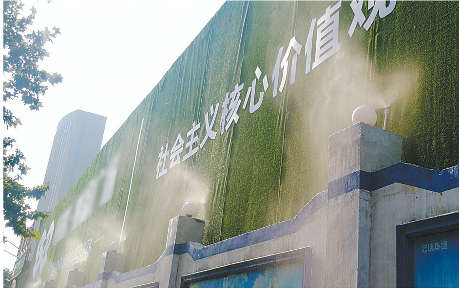
为了做好环境污染防治工作,8月1日,市区建设路中段一在建项目工地开启外墙上的喷淋系统向工地内外喷洒水雾抑制扬尘。本报记者 姜涛 摄
