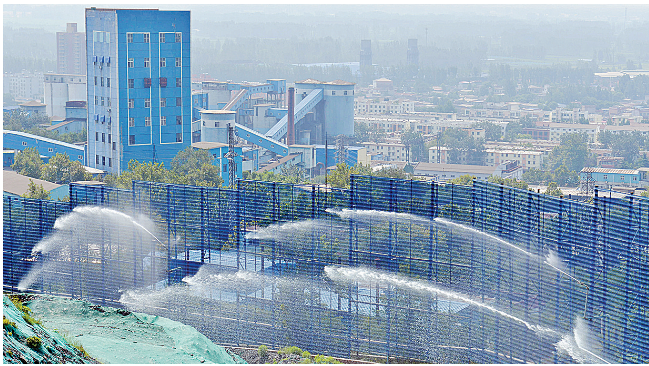
7月24日上午,喷淋设施正在对平煤神马集团八矿北侧进行喷淋抑尘,旁边还设有防尘网、抑尘网等。为防止大风天气矿区出现扬尘造成大气污染,确保生产时有防尘抑尘,去年10月以来,平煤神马集团组织各矿对原有露天煤场进行了全封闭改造,在原有露天煤场上栽种草进行绿
