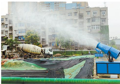
6月4日,位于市区矿路与诚补路交叉口附近的一建筑工地开启远程雾炮机实施雾炮抑尘作业。为做好污染防治工作,该工地使用防尘网对施工区域进行覆盖,并设置远程雾炮机实施雾炮抑尘作业,努力消除扬尘污染隐患。 本报记者 王尧 摄
