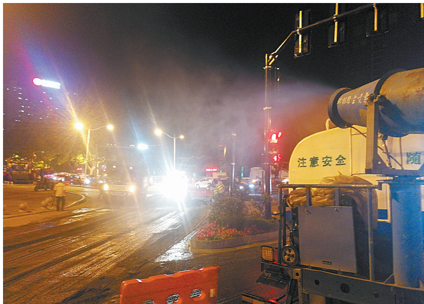
6月2日晚,一辆雾炮车在建光岗道路改造施工现场喷淋降尘。为了做好大气污染防治工作,市城管处有关部门组织雾炮车在建光岗道路改造施工现场,配合施工适时喷淋,减少扬尘污染。
