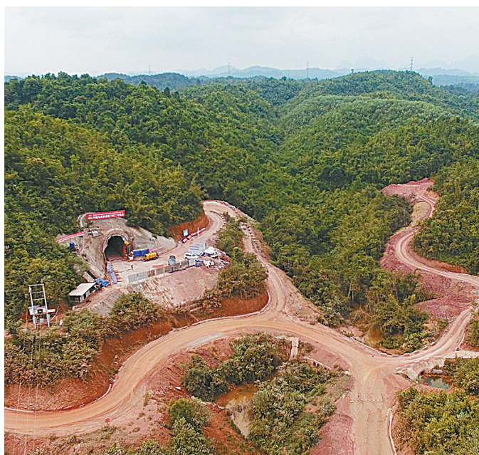
这是2017年12月13日在老挝万象省拍摄的旺门村二号隧道。
