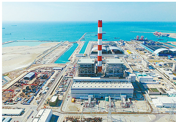
这是2018年4月6日在越南南部平顺省拍摄的永新燃煤电厂一期BOT项目的鸟瞰图。
