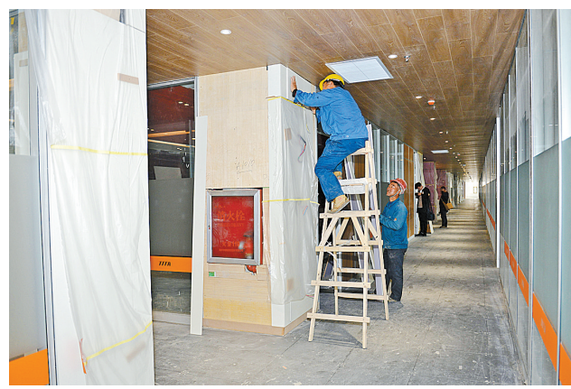
建设高科技产业园
