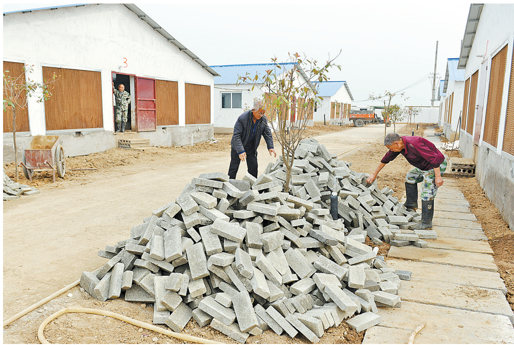
4月24日,村民在叶县仙台镇南关村村畜牧养殖产业扶贫基地建设沼气池。叶县积极围绕“百亩田、千头猪、生态示范方”的循环农业模式发展做文章,同时把“千头线”建设与产业扶贫结合起来,贫困户可通过流转土地、到“千头线”务工等多种方式增加收入,每条“千头线”还可带动10户贫困户享受政策性分红。据了解,去年该县建成投产106条“千头线”,直接带动脱贫1000多户。本报记者 牛智广 摄
