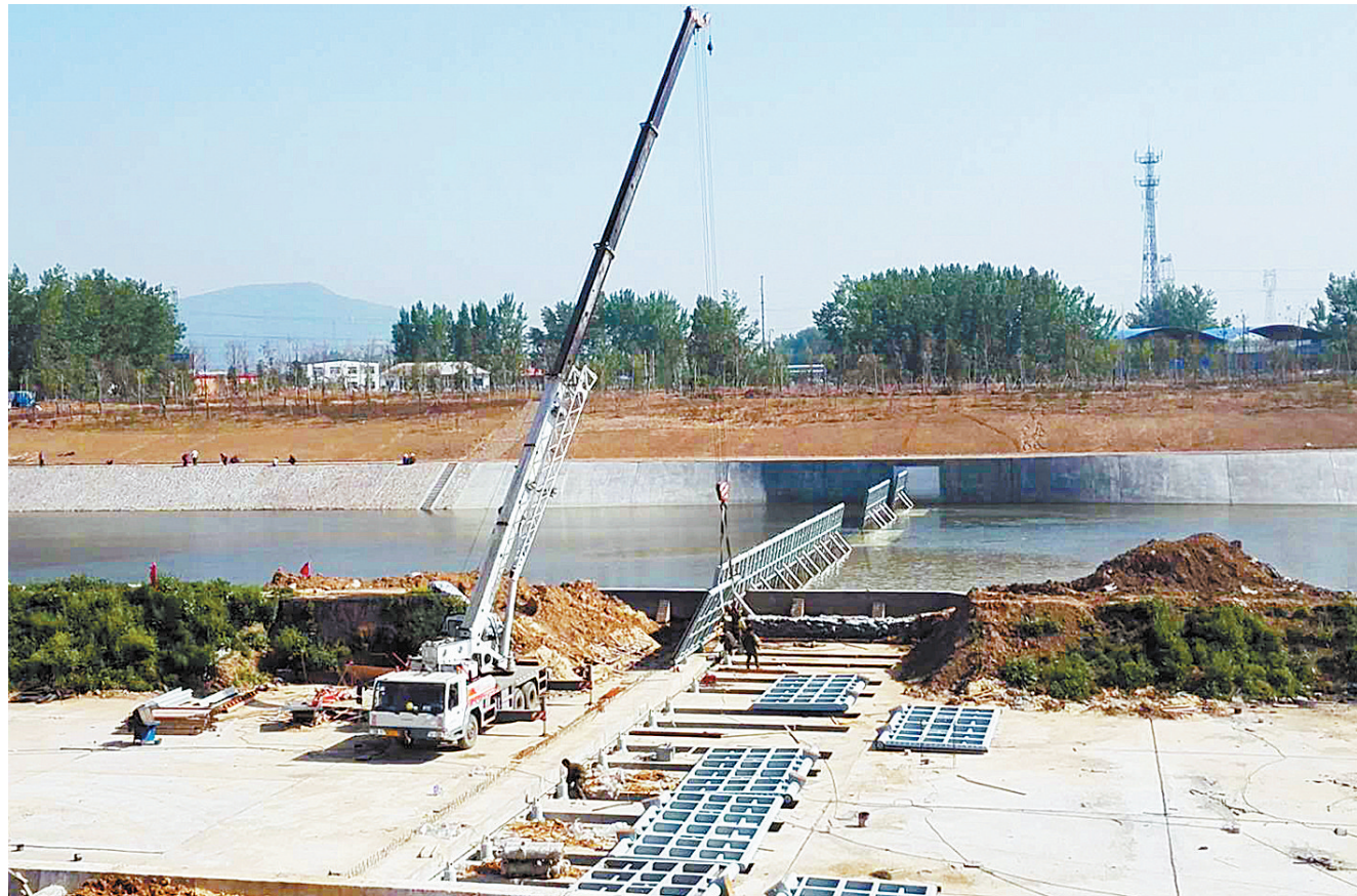
加快推进许南路液压坝工程
