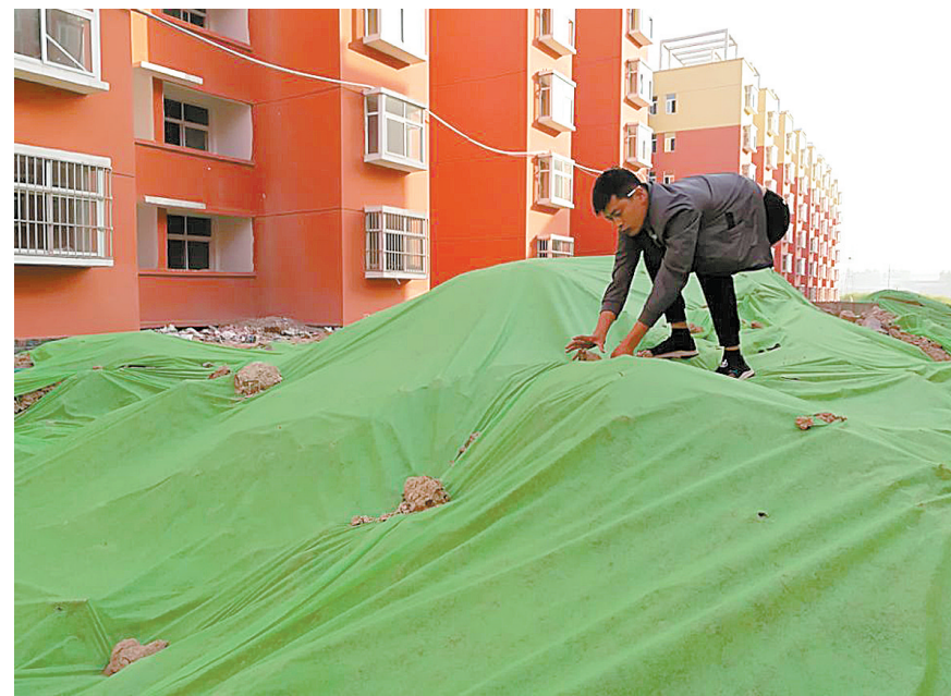
4月18日早上7点,石龙区第三安置小区建筑工程扬尘污染防治监督员田先生用石块压实松动的防尘网。为做到施
