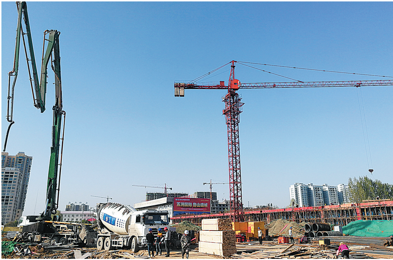
↑4月8日,鲁山五洲国际商贸城项目工地一派繁忙景象。
