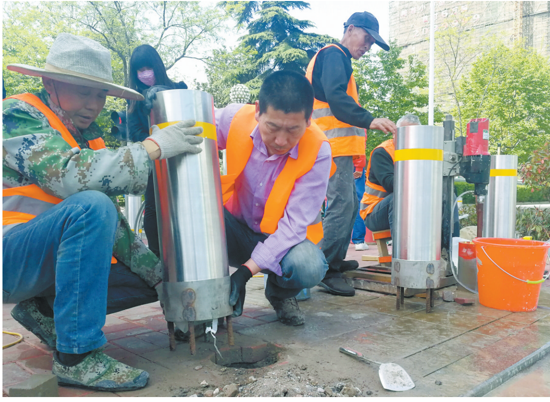
为了确保市民安全出行,并进一步规范交通秩序,4月8日,市城管处组织施工队伍,在建设路与光明路交叉口的安全岛上安装隔离桩。
