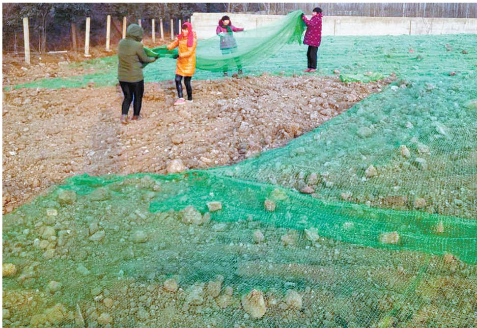
3月3日，工人们在淇河治理景观绿化第二标段施工现场用防尘网覆盖裸土。
