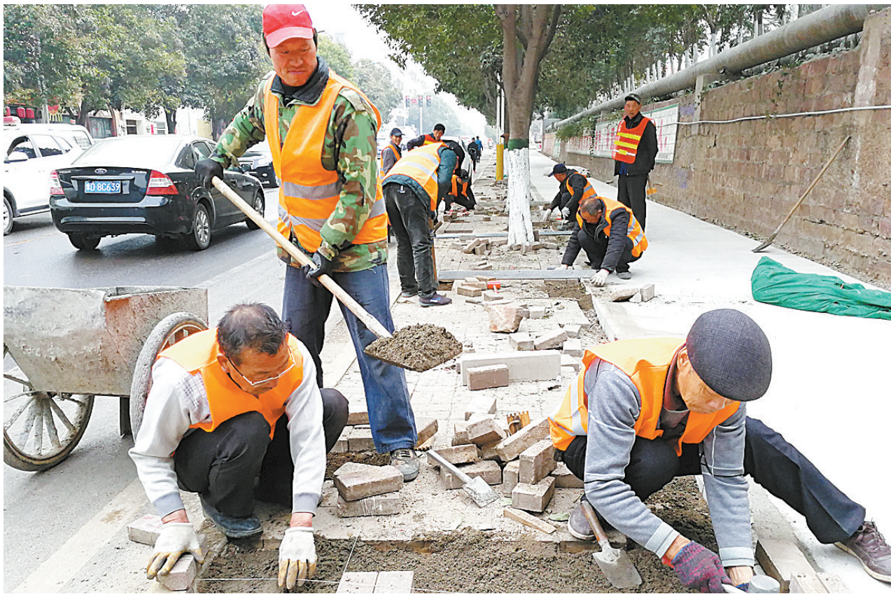
2月26日，施工人员在湛北路道路交通优化建设施工工地铺设水泥路面和人行道道砖。据了解，该工程主体为湛北路南侧人行道改建慢车道，工程西起光明路，东至开源路，预计3月底可具备通行条件，工程全部完工后将有效缓解湛北路中段交通压力，并进一步优化该区域通行环境。
