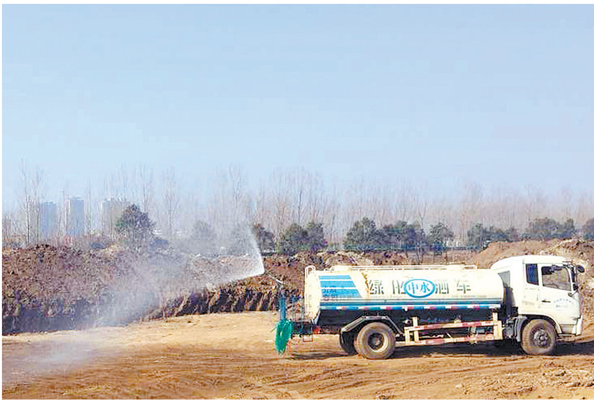
科学组织施工 防治扬尘污染 2月25日,工作人员在湛河治理建设路至高庄沟景观绿化工地驾驶洒水车提前对准备施工的区域实施水雾抑尘作业。 为做好大气污染防治工作,该工地建设单位每天安排洒水车提前对准备开展绿化、景观施工的区域实施水雾抑尘作业,努力从源头上消除扬尘污染。 本报记者 王尧 摄
