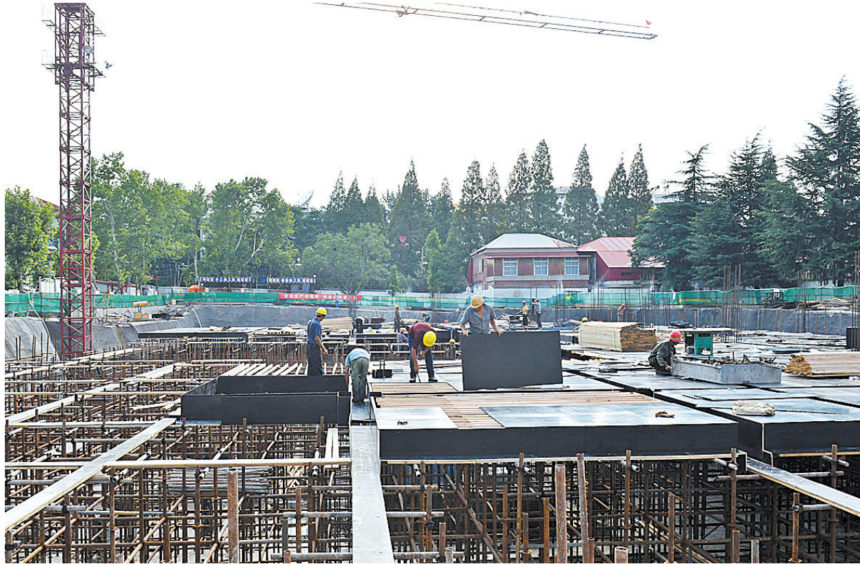
施工人员加紧建设舞钢市中医院门诊医技病房综合楼(资料图片,摄于2017年8月11日)。 本报记者 牛智广 摄
