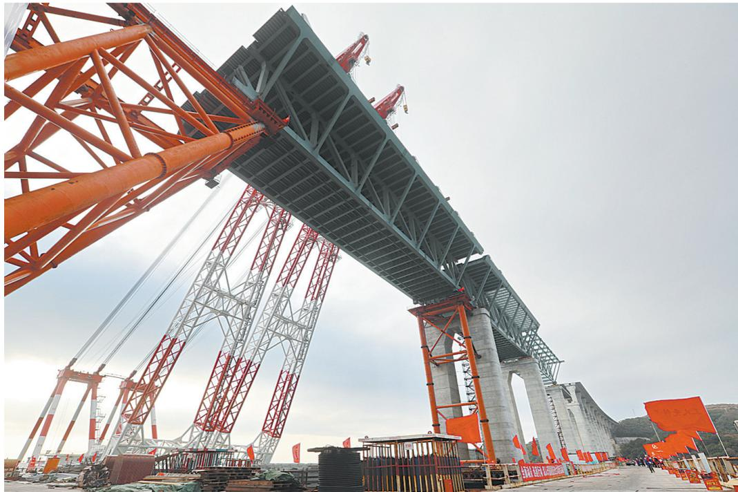
平潭海峡公铁两用大桥首跨3400吨钢桁梁成功架设
