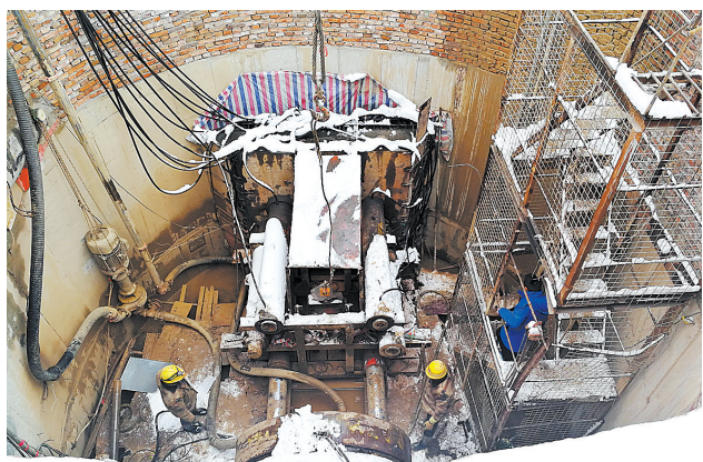
新建湛北干管工程冒雪顶进 本报记者 孙聪利 摄
