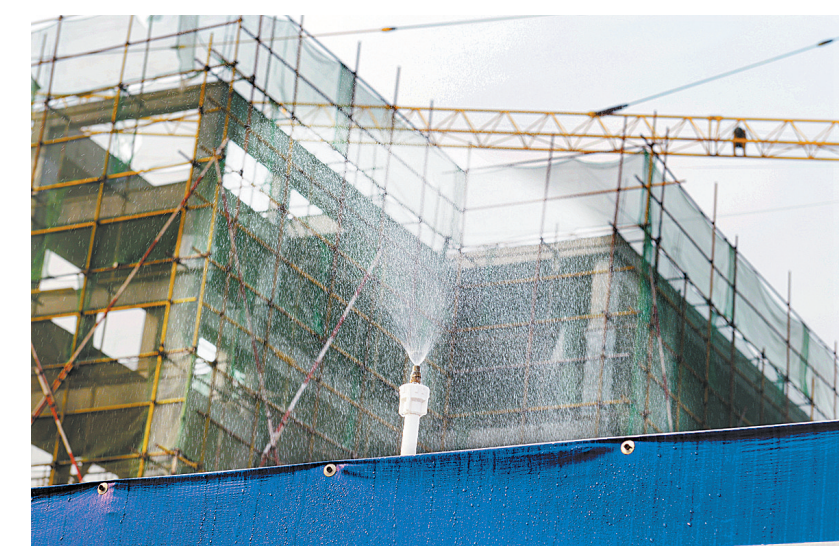
围挡喷淋防扬尘
