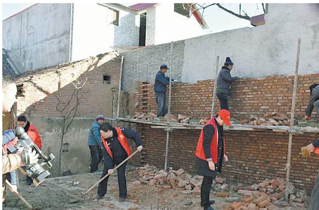
近日,在平遥山报乡马圪塔村,志愿者们帮助困难群众修建院墙。
