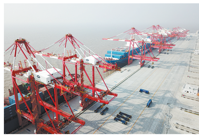
上海洋山深水港四期自动化码头开港试生产
