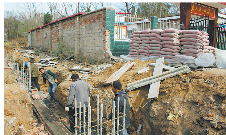
11月22日,瓦屋镇上竹园寺村贫困户雷德文、雷明星等人在该村扶贫车间项目工地上做工。
