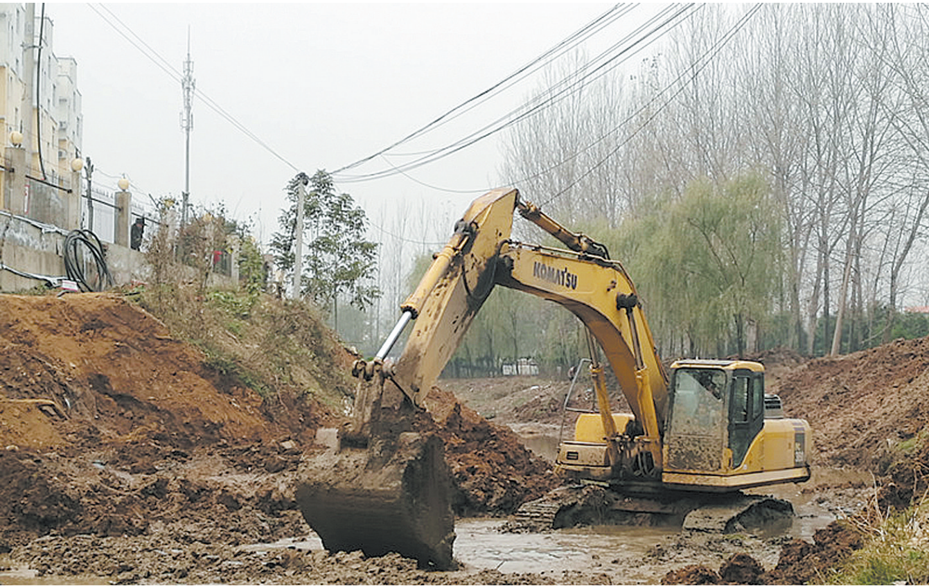
近日,一辆挖掘机在鲁山县城三河铁路桥段施工作业。自实行河长制以来,三河各段河长迅速组织开展清河行动,对河道内的垃圾进行清理,对一些堵塞的部位进行疏通,努力打造河畅、水清、岸绿、景美新环境。 王永安 摄
