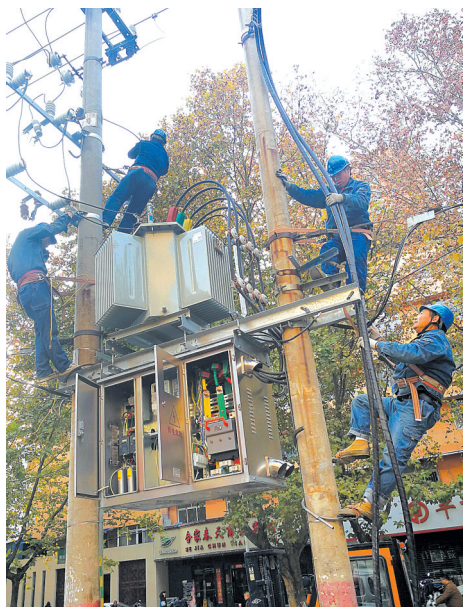
维修线路保障冬季用电
