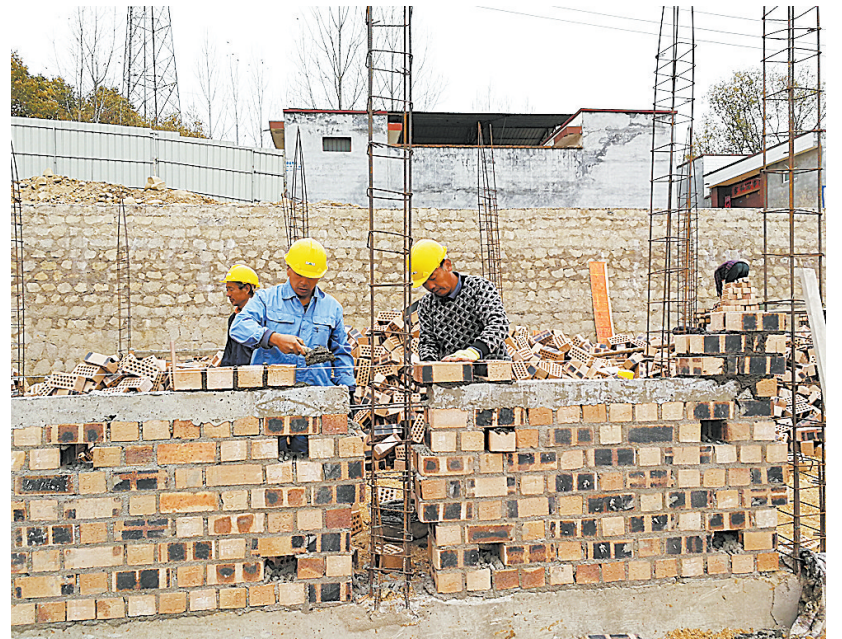
易地搬迁紧张施工
