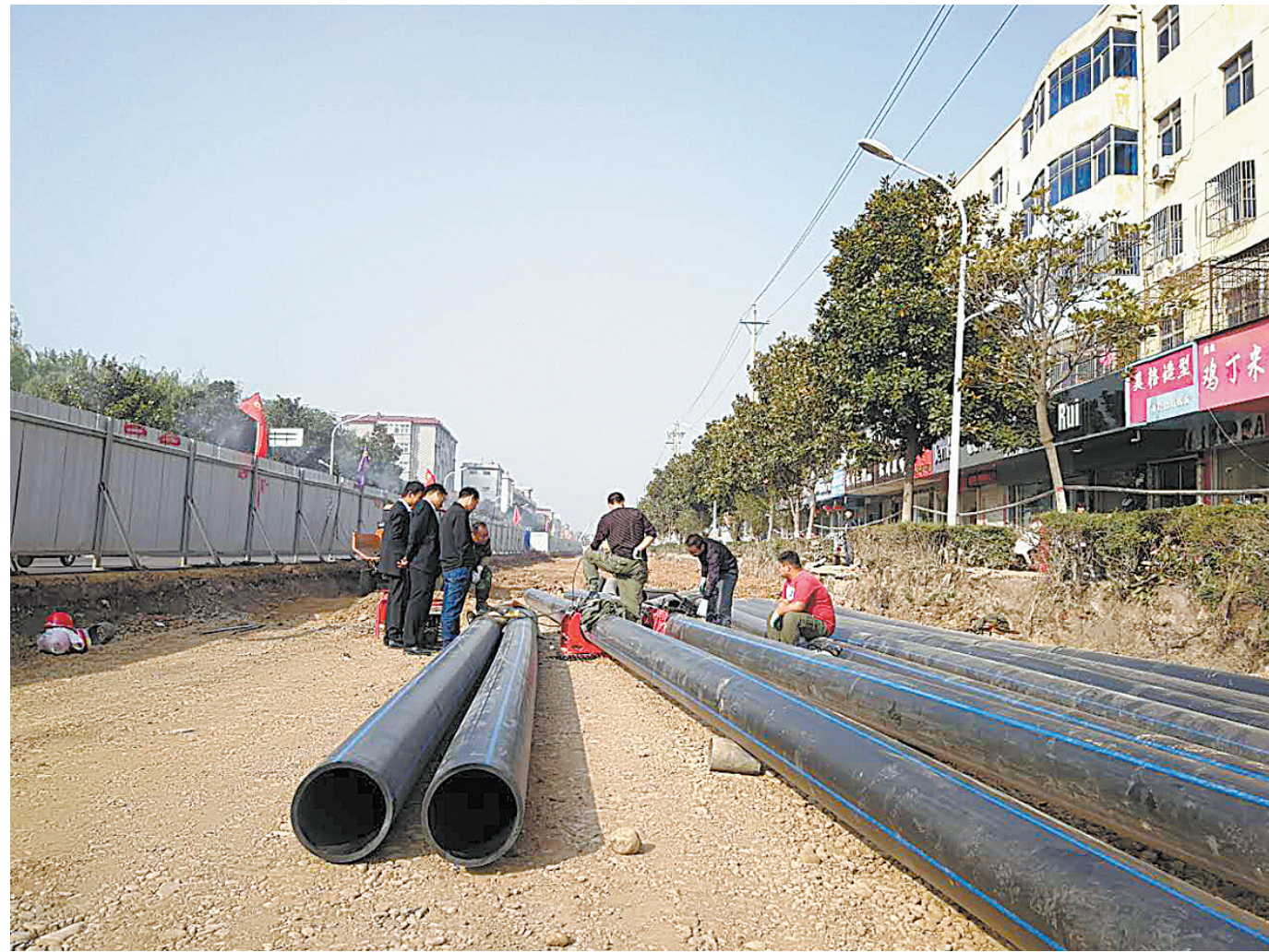
从去年开始,宝丰县对城区104条主次干道和300多条背街小巷进行提档升级改造,改善道路通行条件。图为11月9日,宝丰县人民路提档升级改造现场,施工人员进行管道铺设。 魏广军 摄
