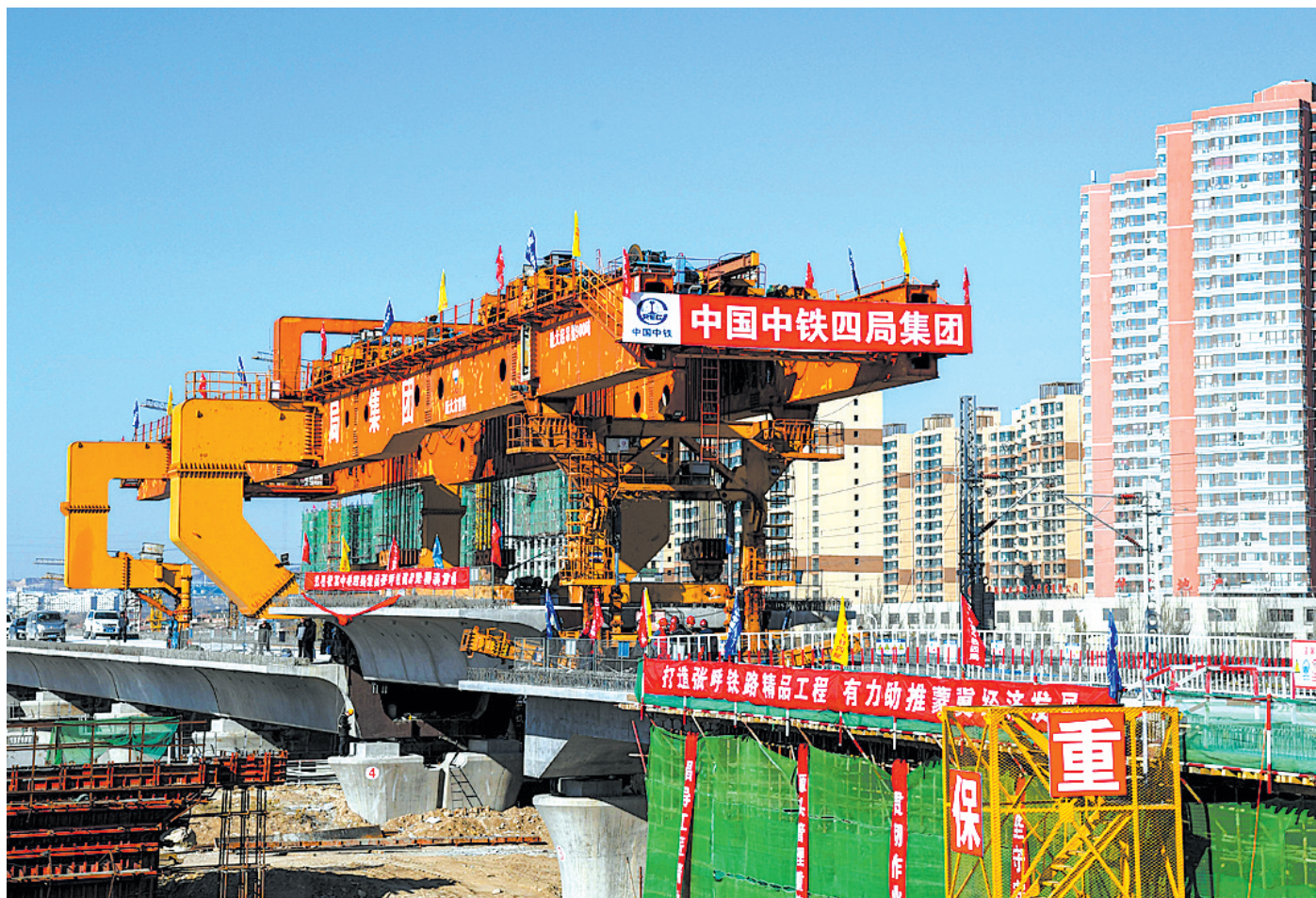
张呼高铁桥梁工程全部完成
