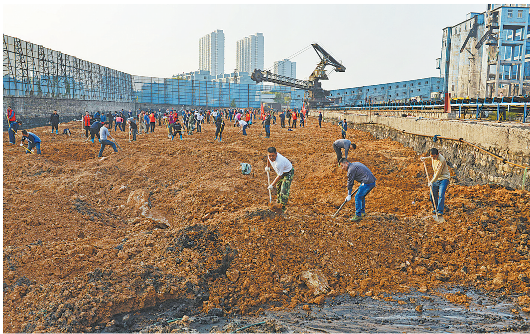
10月27日下午,平煤神马集团六矿员工在将原有的露天煤场用黄土进行覆盖。为助力我市大气污染防治工作,防止大
