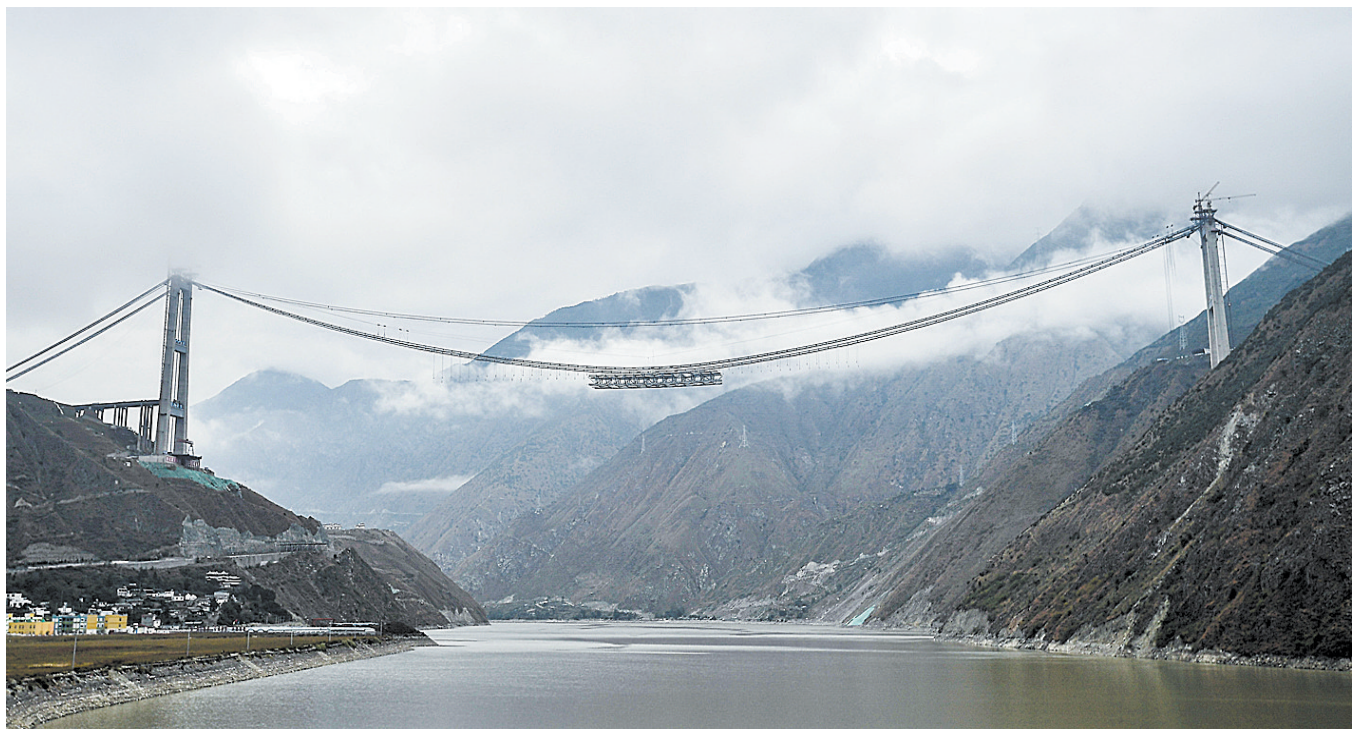
建设中的“川藏第一桥”
